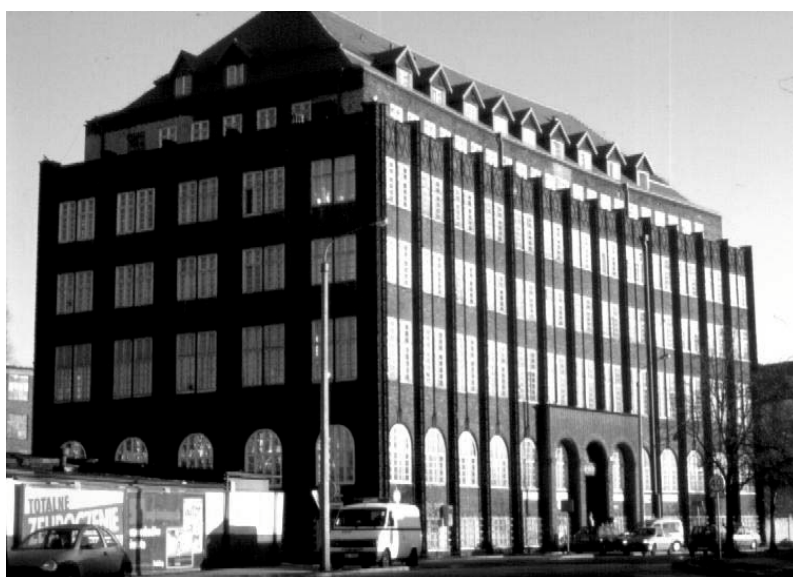
Ryc. 3. Kasa Chorych ( Ortskrankenkasse ), Gdańsk 1925-1927, stan obecny (fot. J. Tarnowski)
